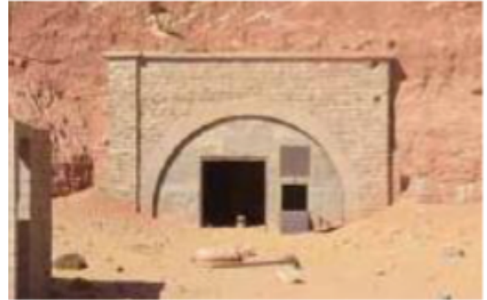
Entrée d'un tunnel sur la zone CEA de Reggane 17 novembre 2007. Photo Bruno Barrillot.
